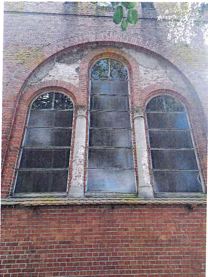
Fot 7. Stan zachowania fragmentu wschodniej ściany prezbiterium. Widoczne znaczne uszkodzenia w obrębie tynku i detalu sztukatorskiego wykonanego.
