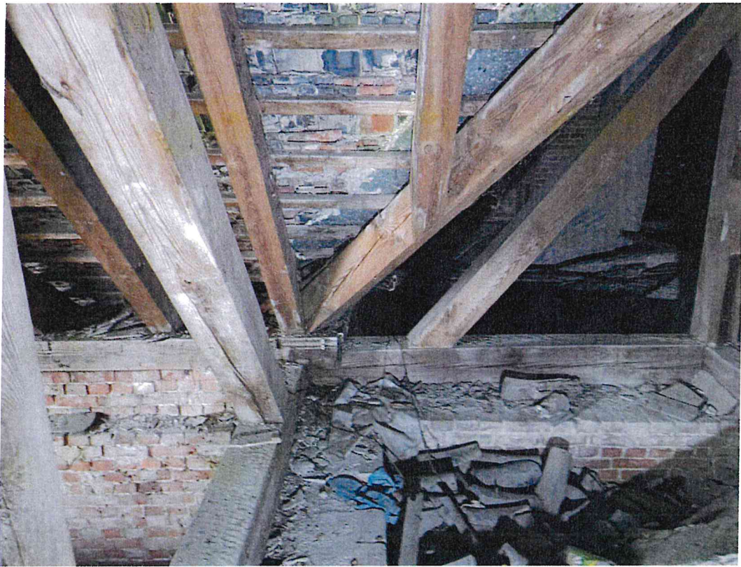
Fot.29. Kościół w Solcu –połączenie belki koszowej z murlatą źródło: własne (sierpień 2023)
