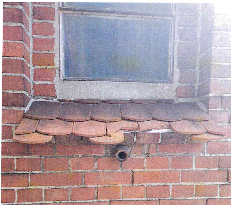
Fot 8. Uszkodzenia w obrębie parapetów wykonanych z dachówki ceramicznej.
