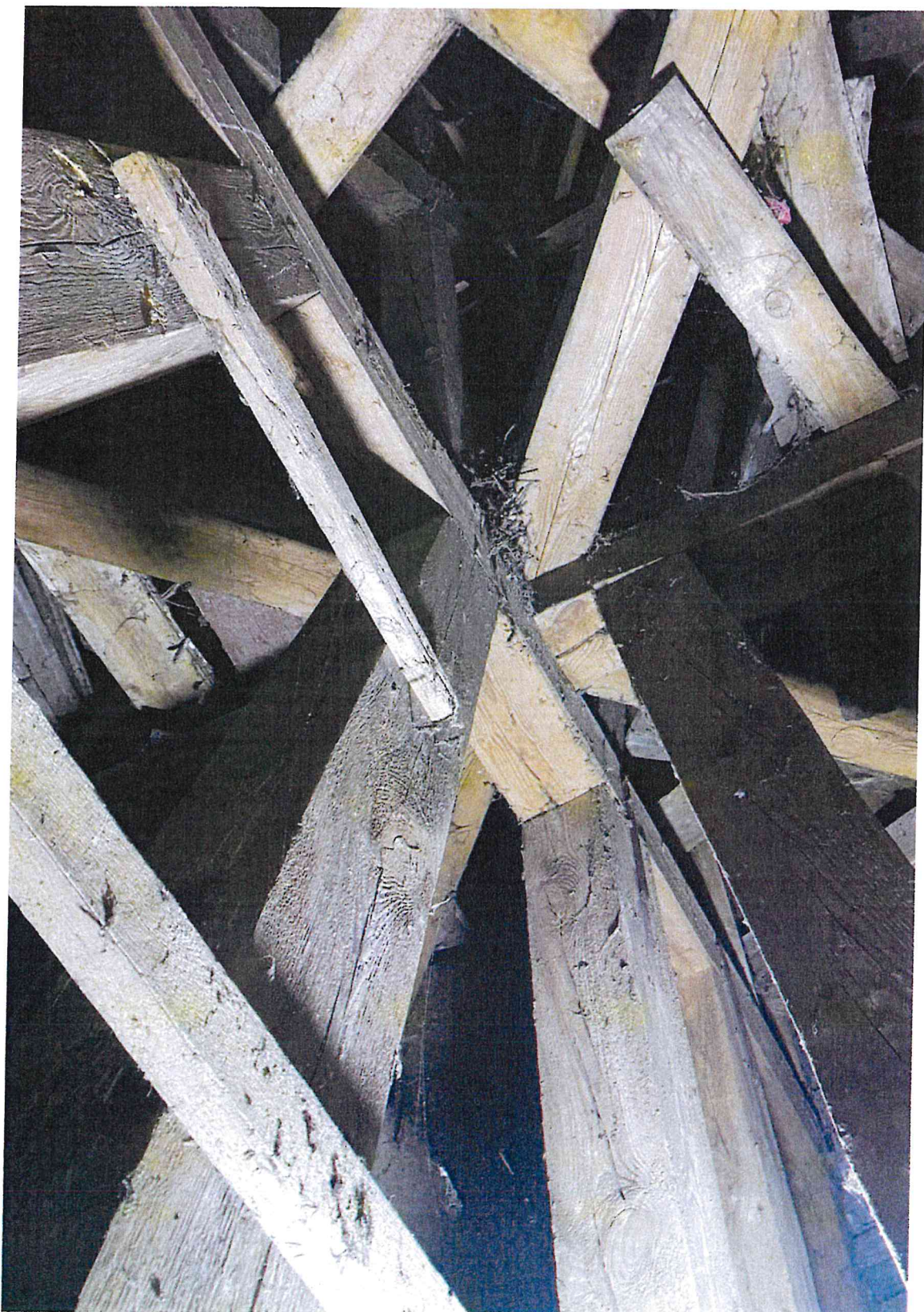
Fot.13. Kościół w Solcu – konstrukcja więzy, źródło: własne (sierpień 2023)
