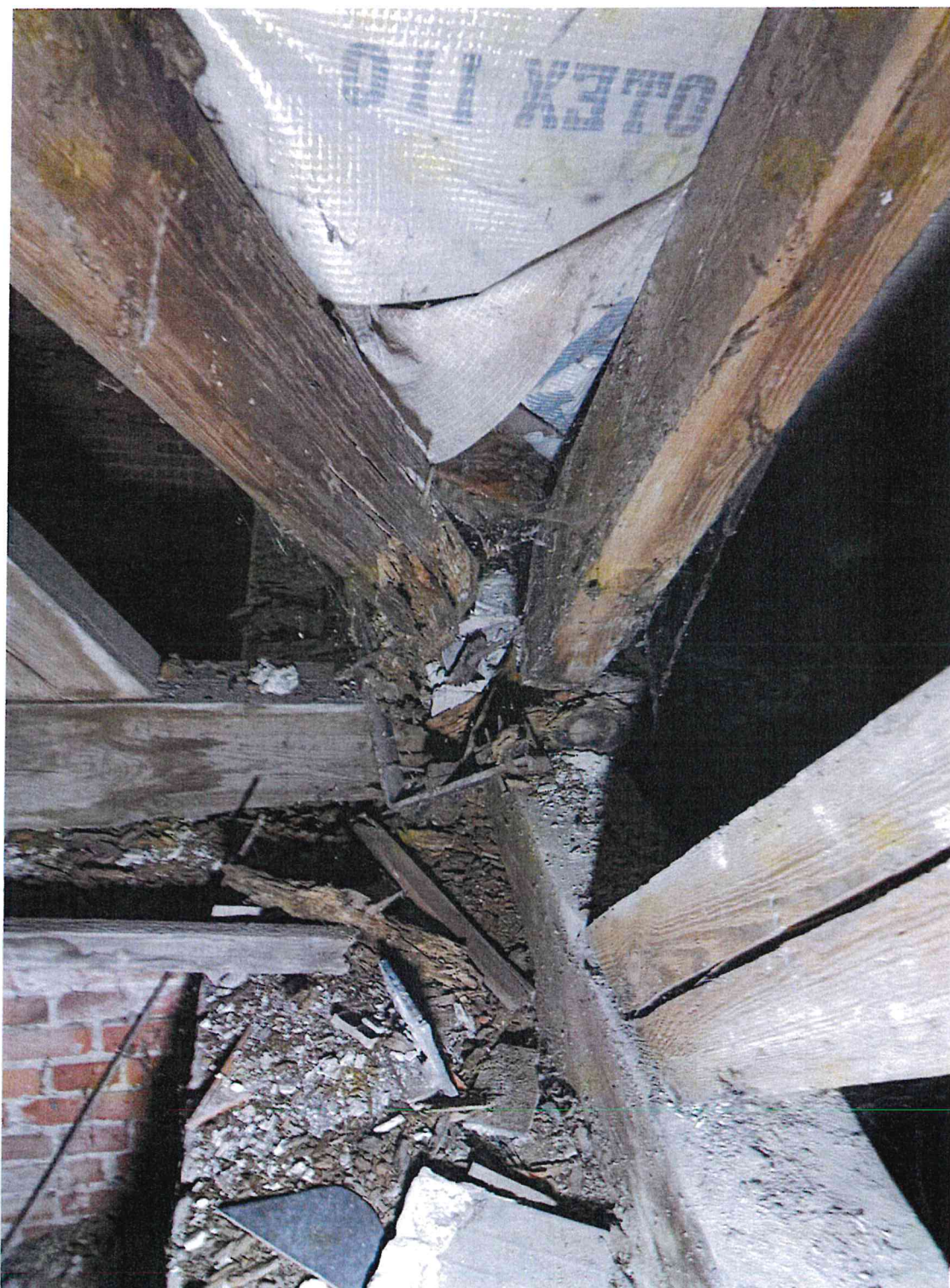
Fot.28. Kościół w Solcu –połączenie belki koszowej z murlatą źródło: własne (sierpień 2023)
