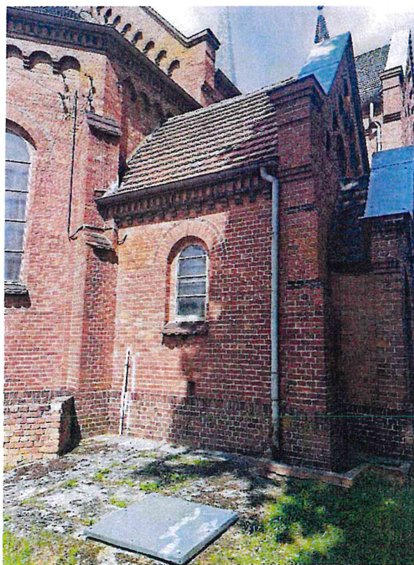
Fot 5 i 6. Stan zachowania fragmentu muru prezbiterium od strony południowej. Widoczny granitowy fundament. Na kolejnym zdjęciu południowa ściana zakrystii z charakterystycznym zębatym gzymsem wspartym na schodkowych konsolach.
