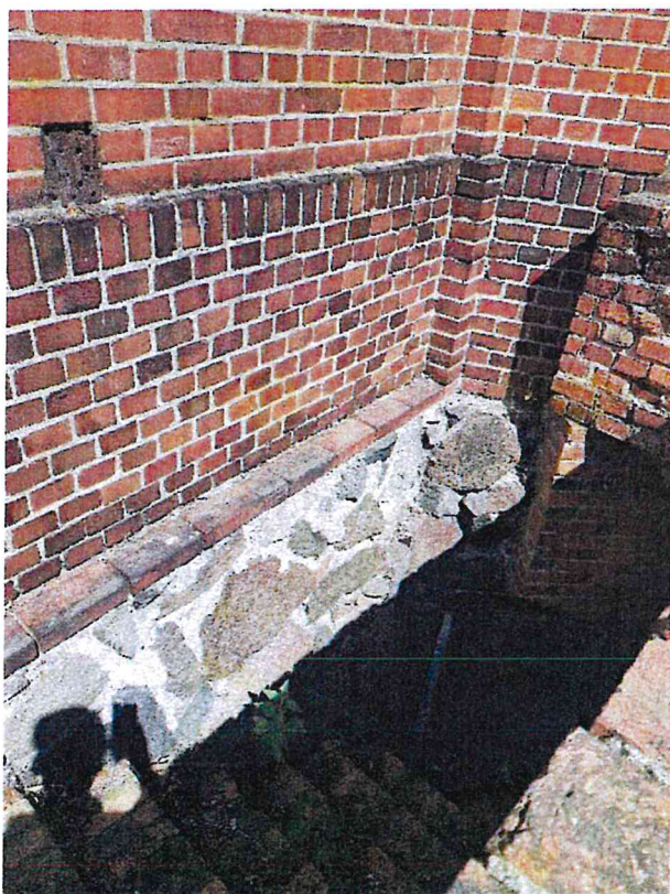
Fot 5 i 6. Stan zachowania fragmentu muru prezbiterium od strony południowej. Widoczny granitowy fundament. Na kolejnym zdjęciu południowa ściana zakrystii z charakterystycznym zębatym gzymsem wspartym na schodkowych konsolach.
