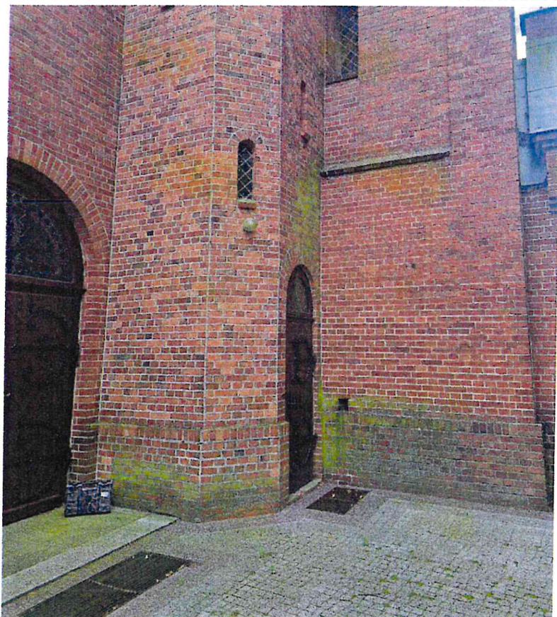
Fot 9 i 10 (poniżej) . Stan zachowania patii cokołowej. Widoczne znaczna korozja biologiczna w obrębie narożnika północno-wschodniego wieży. W części cokołowej pojawiły się wykwity soli.
