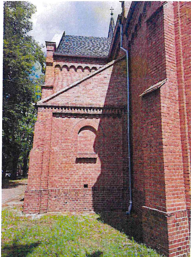
Fot 3 i 4. Ogólny stan zachowania prezbiterium od strony południowej a także zachodniej kaplicy. Widoczna tzw. fałszywa patyna – zabrudzenia o charakterze sadzastym w obrębie ceglanego cokotu.
