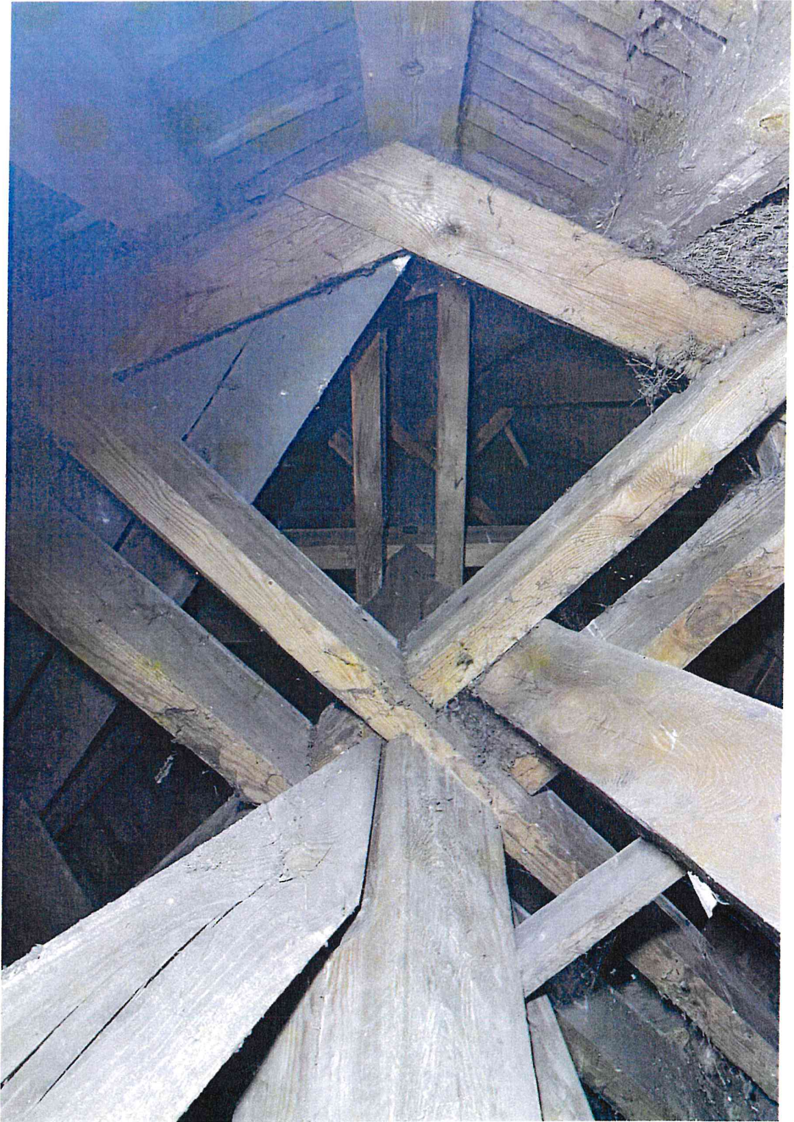
Fot.22. Kościół w Solcu – konstrukcja więźby, źródło: własne (sierpień 2023)
