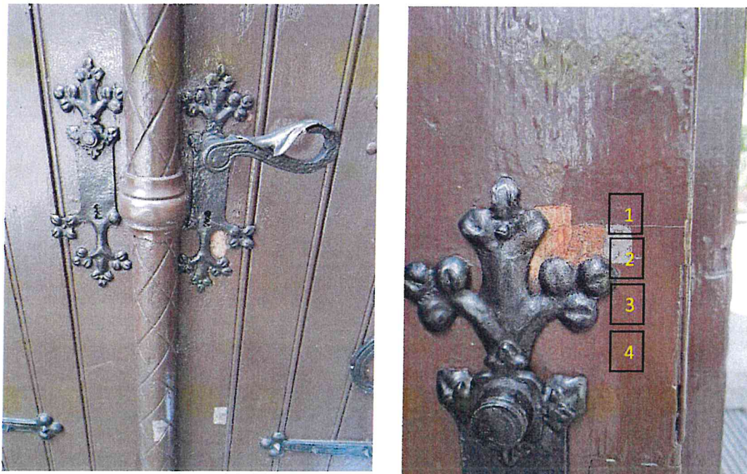
Odkrywka nr 2. Wykonana na fragmencie drzwi głównych prowadzących do kościoła
