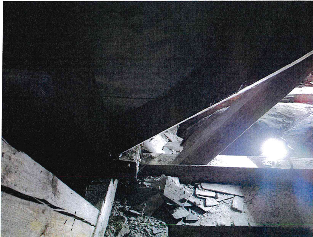
Fot.30. Kościół w Solcu –połączenie belki koszowej z murlatą źródło: własne (sierpień 2023)
